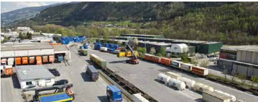
Abbildung: Terminal Hall in Tirol
