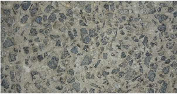
Abbildung 2: Typische Waschbetonstruktur von Straßenoberbeton
