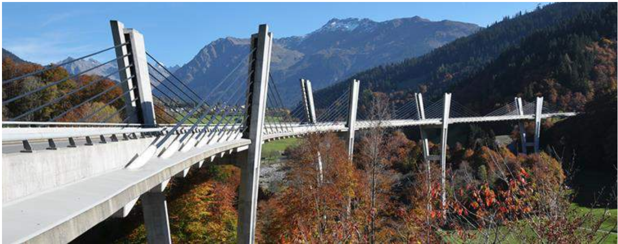
Abbildung 1: Beispiel einer integral ausgeführten Brücke (Sunnibergbrücke) [1]
