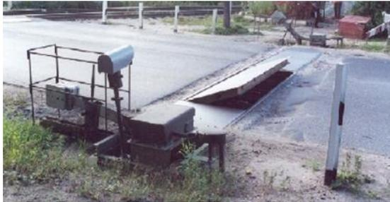
**Abbildung 26: Beispiel einer verstellbaren Rampe**
