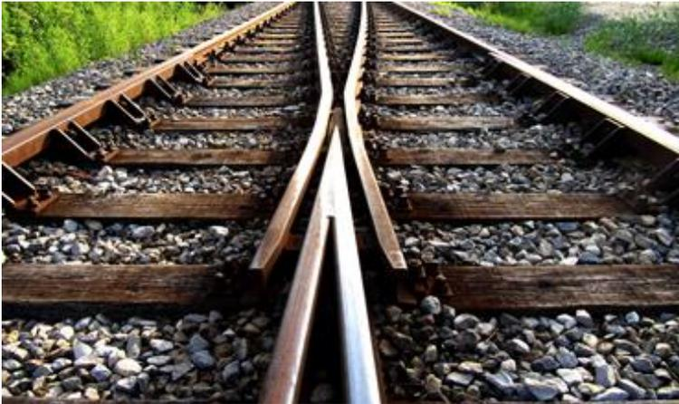
ABB 2. Bahnschwellen aus Holz, imprägniert mit Kreosot (Foto: pixelio.de /Rainer Sturm)
