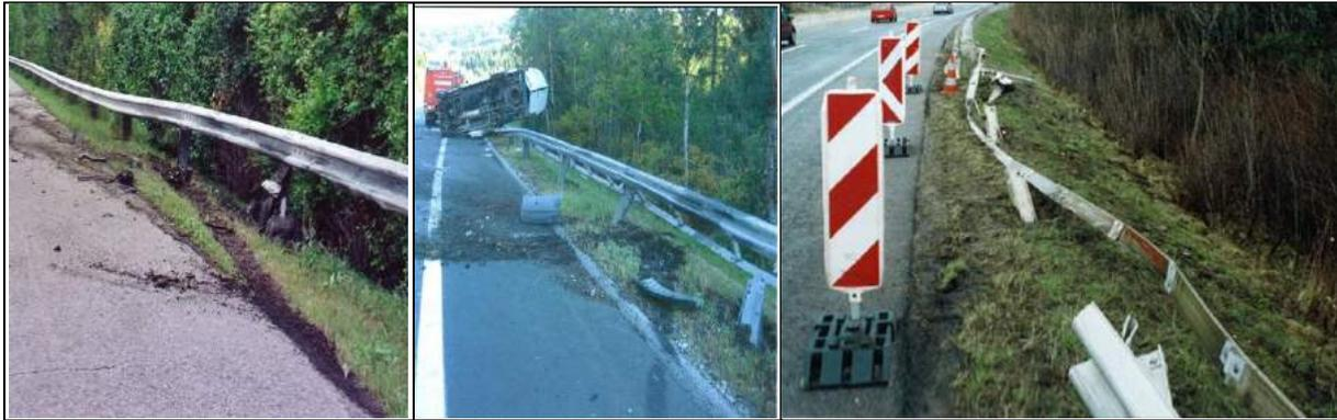
Abbildung 35: Kollisionen mit Schutzeinrichtungen ohne Fahrzeugdurchbruch
