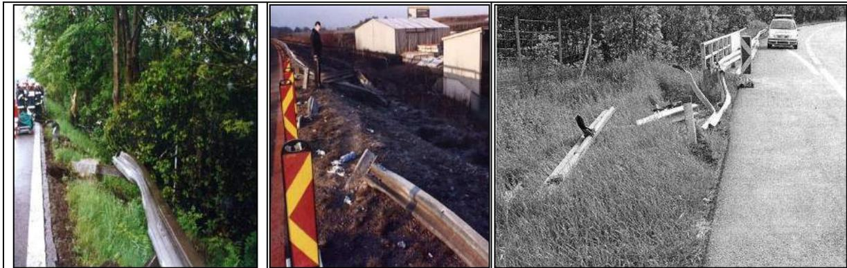
Abbildung 36: Kollisionen mit Schutzeinrichtungen mit Fahrzeugdurchbruch
