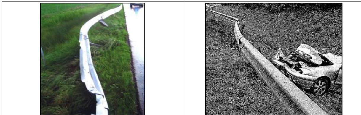
Abbildung 37: Kollisionen mit Schutzeinrichtungen mit Fahrzeugdurchbruch
